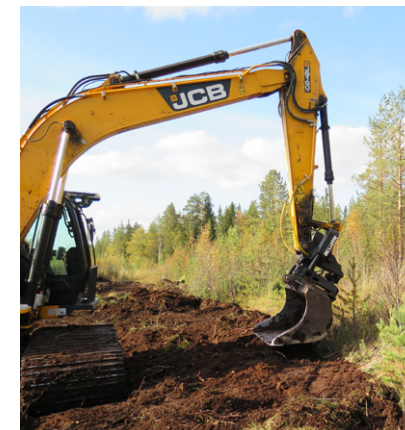
Kaivinkone työssään. Kuva: Pauliina Kulmala
